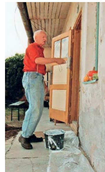
J. Hromek při opravě Starého kvartýru v roce 2005
