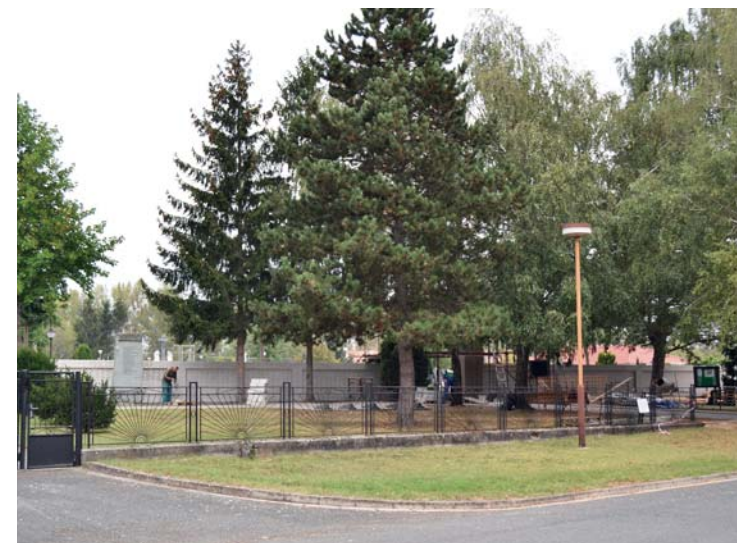
Rekonstrukce hřbitovní zdi
