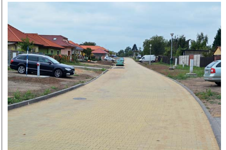
Nová komunikace na ulici Kratiny
