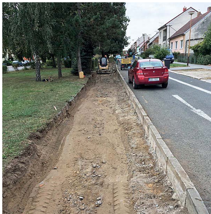
Odstavné plochy ul. Velkomoravská za kostelem
