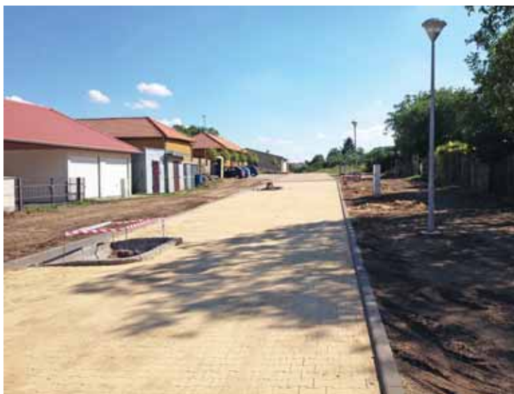
Rekonstrukce ulice Kratiny, červenec 2016
