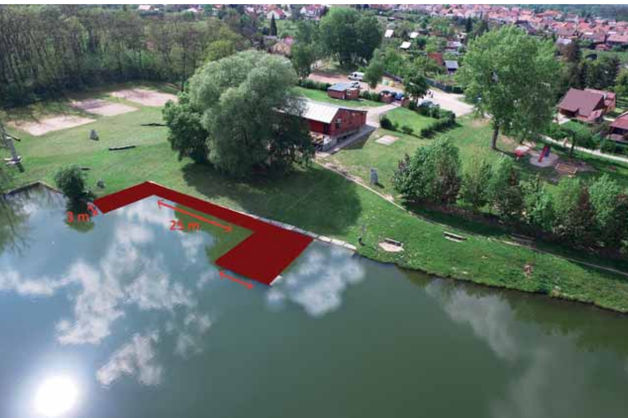
Na podzim tohoto roku proběhne rekonstrukce mola na Cihelně
