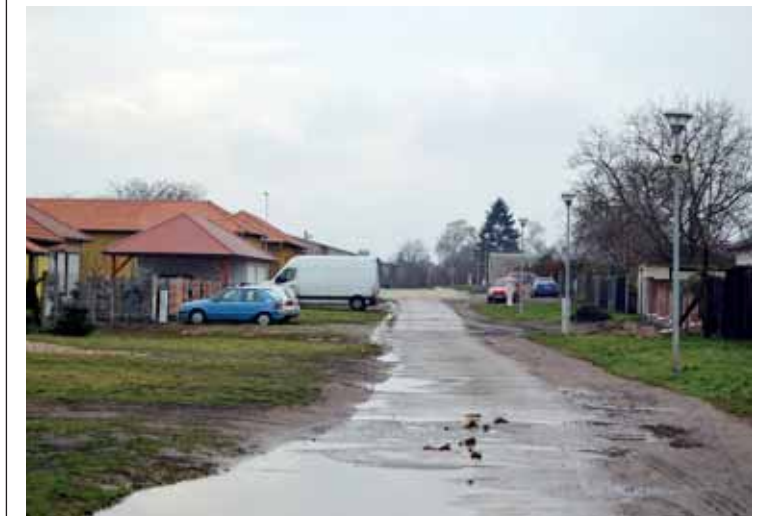
Stav komunikace v ulici Kratiny před zahájením rekonstrukce foto: Denisa Šimíková
