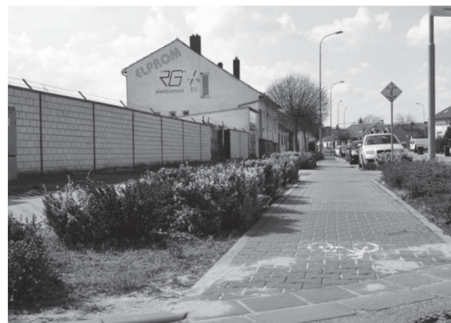
Na základě požadavků občanů probíhá v ul. Velkomoravská úprava stávajících nájezdů chodníků a cyklostezky na bezbariérové
