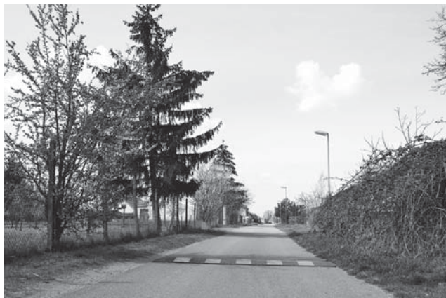
Na základě požadavků občanů byly instalovány retardéry v ulicích U Vrchnice, Zahrádkářská a Dvorní
