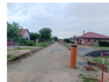
Výstavba a rekonstrukce komunikace U Vrchnice
