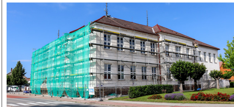
Rekonstrukce základní školy
