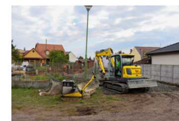
Výstavba venkovního skladu materiálu
