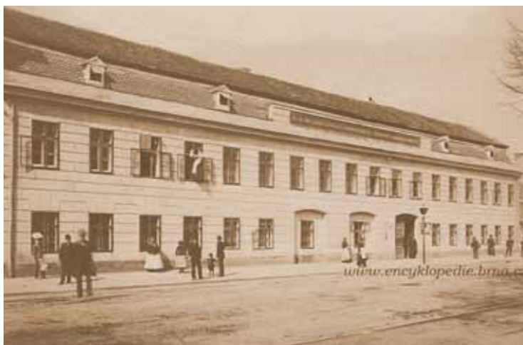
Robotárna na Lidické ulici v Brně
