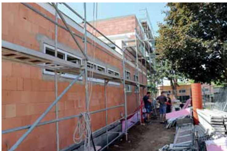
Přístavba kuchyně MŠ
