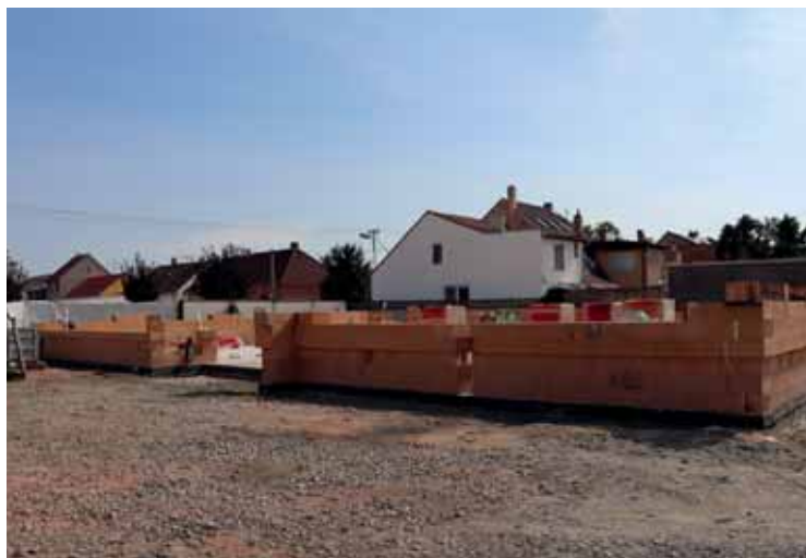
Výstavba Domu zdraví
