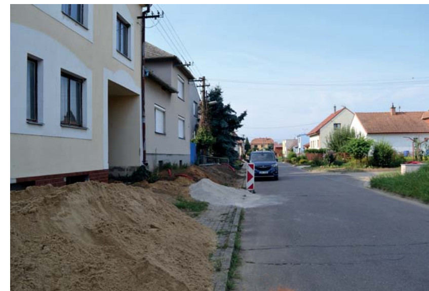
Pokládka veřejného osvětlení na ul. Záhumní foto: Petra Lorencová
