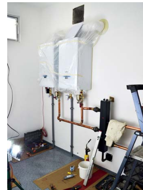
Rekonstrukce kotelny foto: Petra Lorencová
