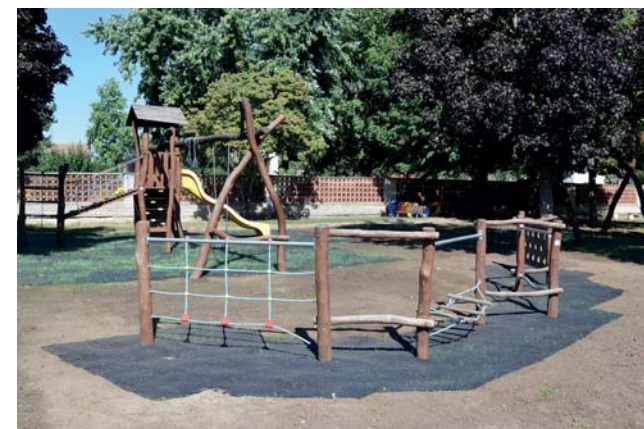
Nové dopadové plochy na hřišti v MŠ
