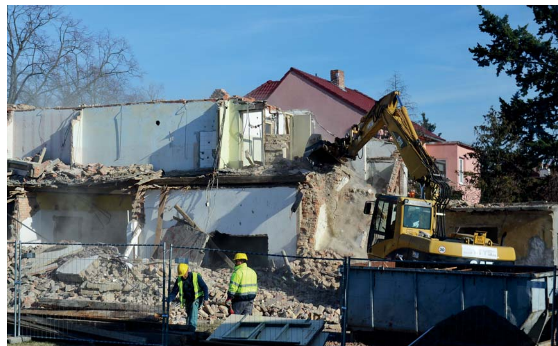
Demolice zbytku budovy bývalého kina
