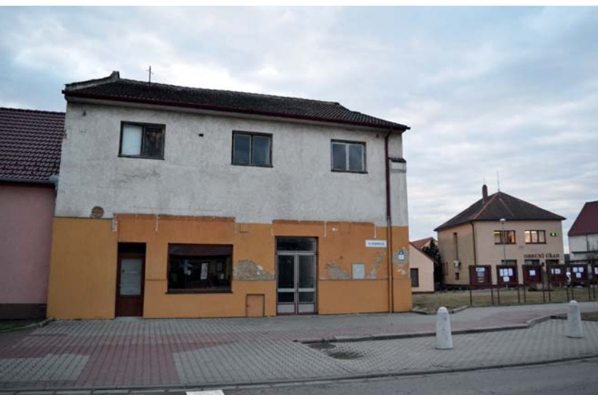
Demolice zbytku budovy bývalého kina
