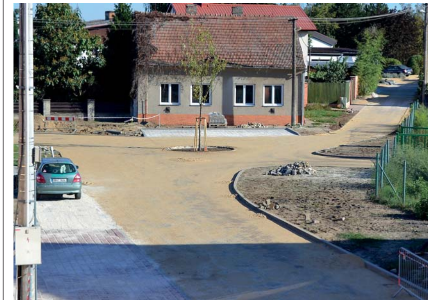
Výstavba komunikace ul. Česká
