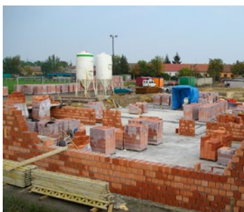
Výstavba sportovní haly, foto: Petra Lorencová
