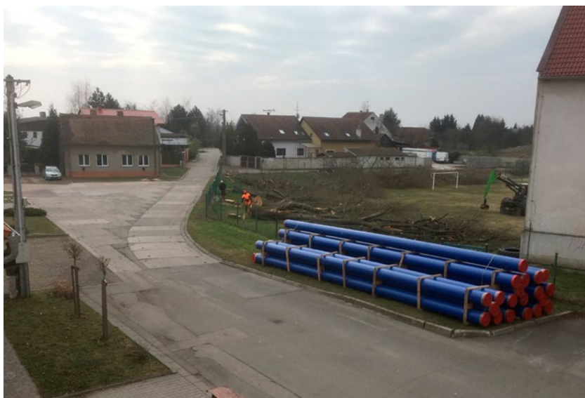
Potrubi pro opravu vodovodu Podluží, foto: Petra Lorencová
