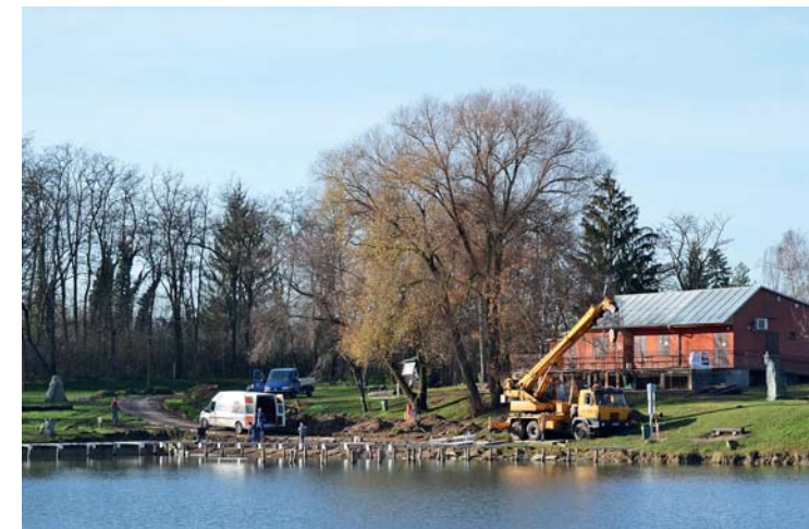
Rekonstrukce mola vodní nádrže Cihelna
