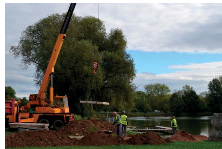
Položení panelové cesty v areálu Cihelna
