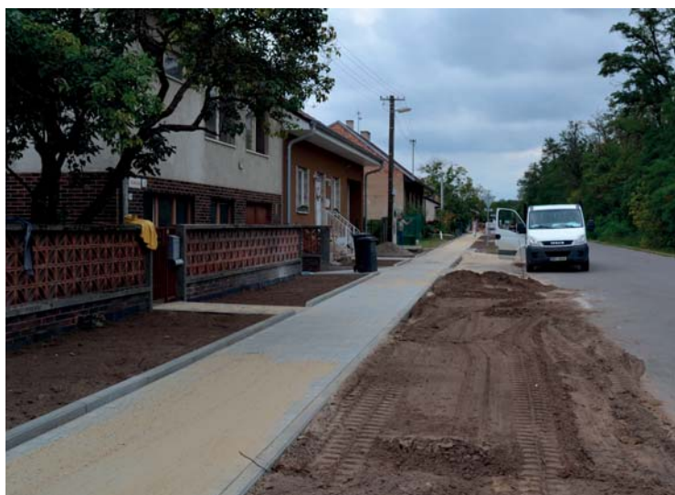
Výstavba chodníku na ulici Bojanovická
