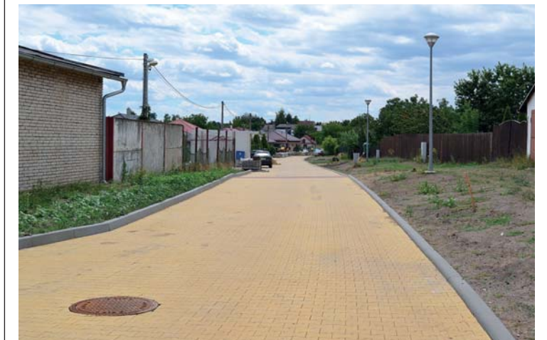
Výstavba komunikace v ul. Kratiny
