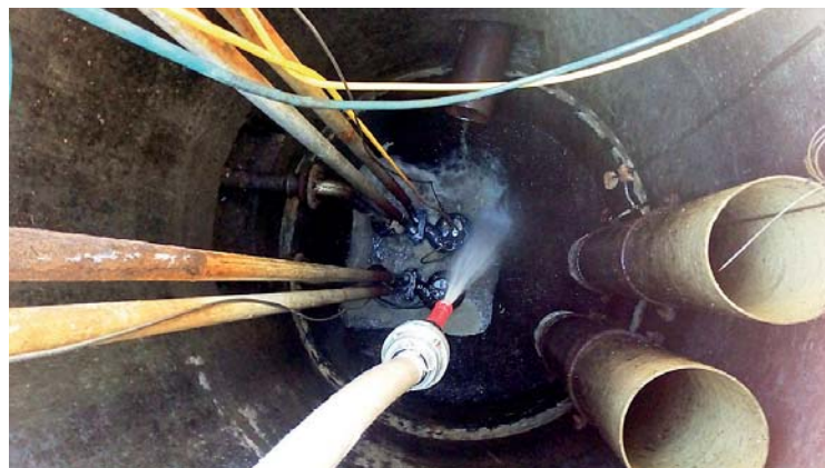
Čištění jímek čerpacích stanic
