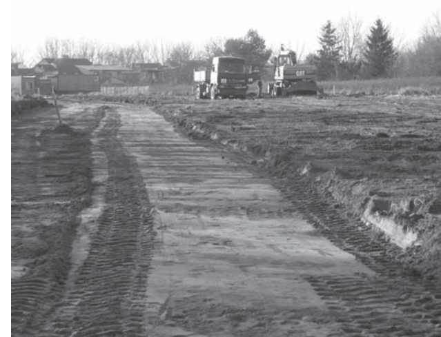
Pohled ze staveniště směr ulice Vinohrádky
