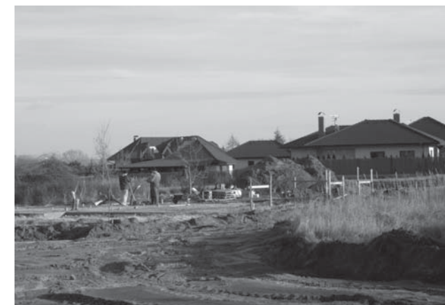
Výstavba prvního RD je již zahájena
