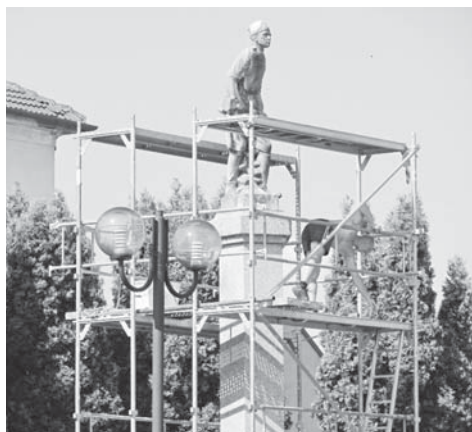
Probíhající opravy památníku.
