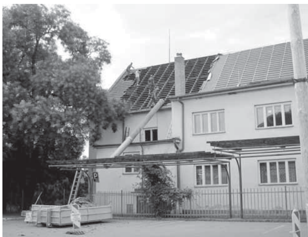
Oprava severní části střechy
