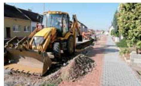
Rekonstrukce ulice Velkomoravská
