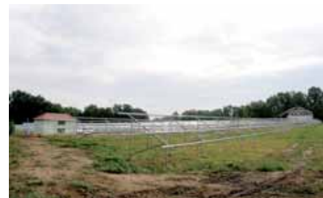
Výstavba fotovoltaické elektrárny
