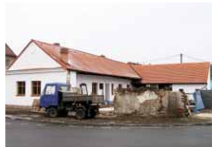
Rekonstrukce budovy Starého kvartýru
