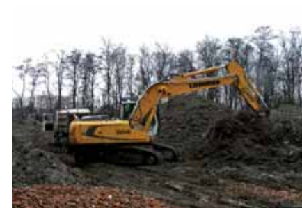
Zahlazování následků hornické činnosti - dekontaminace zeminy pro těžbu ropy v k. ú. Lužice u Hodonína
