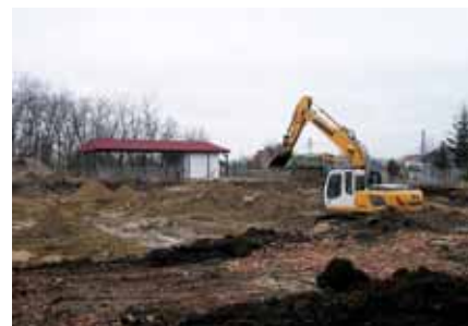
Zahlazování následků hornické činnosti - dekontaminace zeminy pro těžbu ropy v k. ú. Lužice u Hodonína
