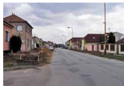
Rekonstrukce ul. Velkomoravská IV. stavba
