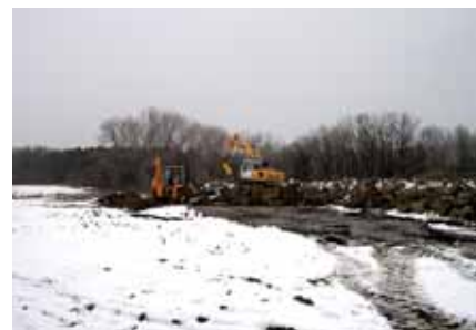
Zahájení výstavby fotovoltaické elektrárny
