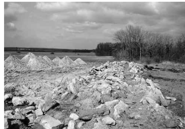
Výstavba fotovoltaické elektrárny v Lužicích.
