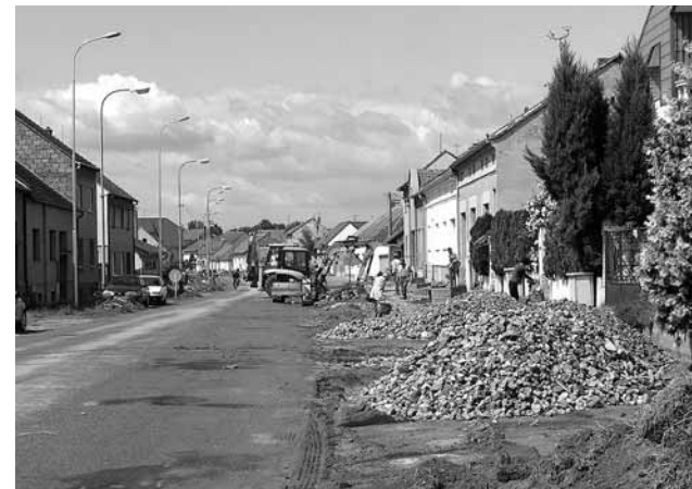
Rekonstrukce ul. Velkomoravská
