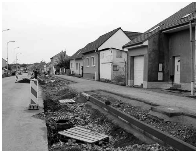
Rekonstrukce ul. Velkomoravská
