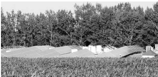
Výstavba fotovoltaické elektrárny v Lužicích.
