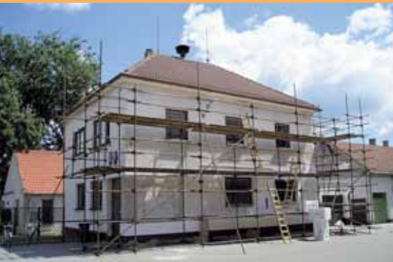
Zateplení a fasáda OÚ
