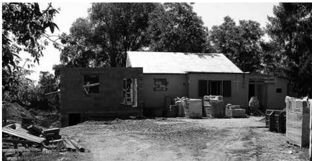
Foto: Přístavba kuchyně
