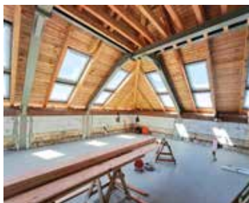
Rekonstrukce základní školy
