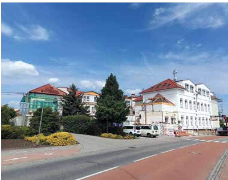
Rekonstrukce základní školy
