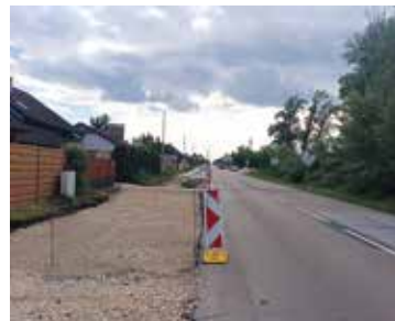
Výstavba nového chodníku
