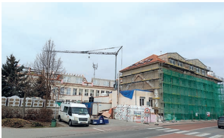
Rekonstrukce ZŠ Lužice
