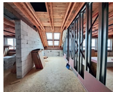
Rekonstrukce ZŠ Lužice
