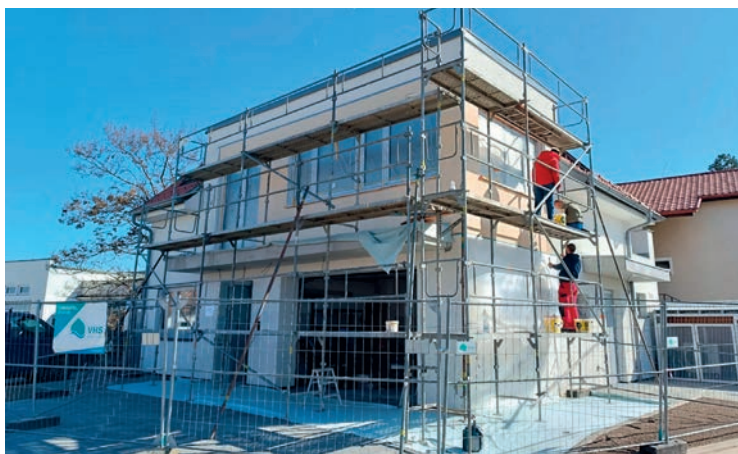
Novostavba služebny obecní policie
