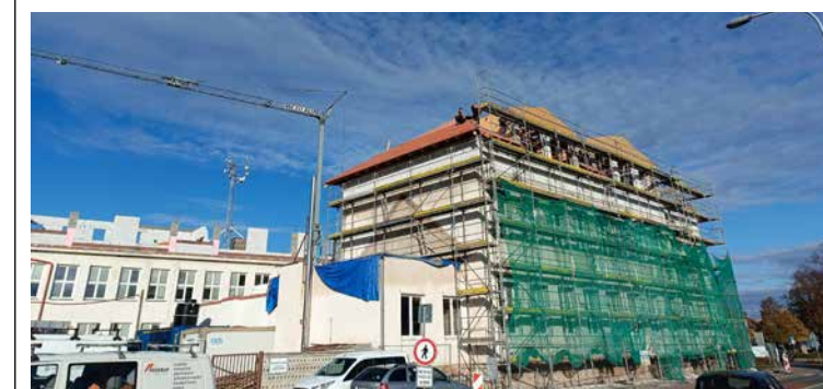
Rekonstrukce základní školy
