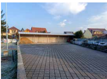
U Vrchnice - Nové skladovací prostory
